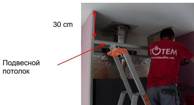
Обеспечить термоизоляцию внутренней поверхности вытяжки и внутренней поверхности пространства между потолком и подвесным потолком. Пространство между потолком и подвесным потолком должно иметь две вентиляционные решетки размером 20 см<sup>2</sup>.
