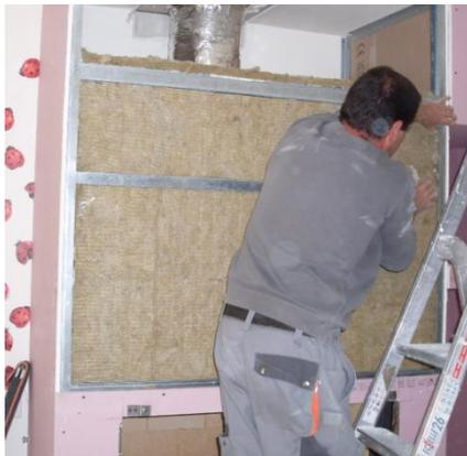
Внутренние поверхности, которые нагреваются от топки и соединительной трубы, должны иметь изоляционный слой.
