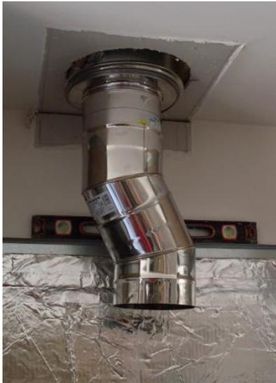
Топка подсоединяется к дымоходу при помощи стандартных металлических труб.
