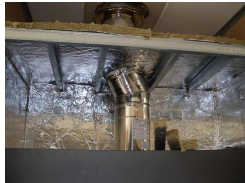
В верхней части, на расстоянии 30 см от потолка необходимо установить подвесной потолок, который будет служить в качестве теплового экрана.
